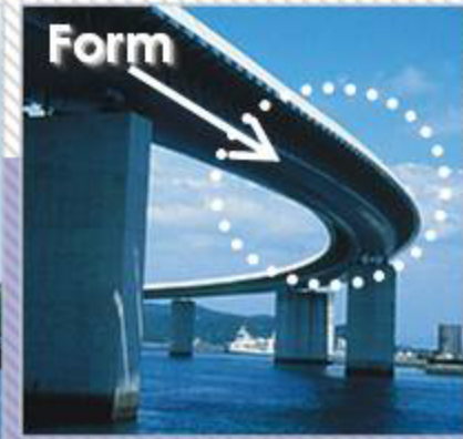
Ushibuka Bridge Ushibuka, 1989/1996
